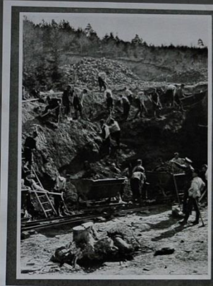
Schwere Erd- und Steinbrucharbeiten in Handflach (Quelle: NA Präg GNP ka 85)
