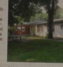
Dieses Gebäude des Ferienhofs Poppom steht auf dem Areal, wo sich einst das Hilfskrankenhaus befand.
